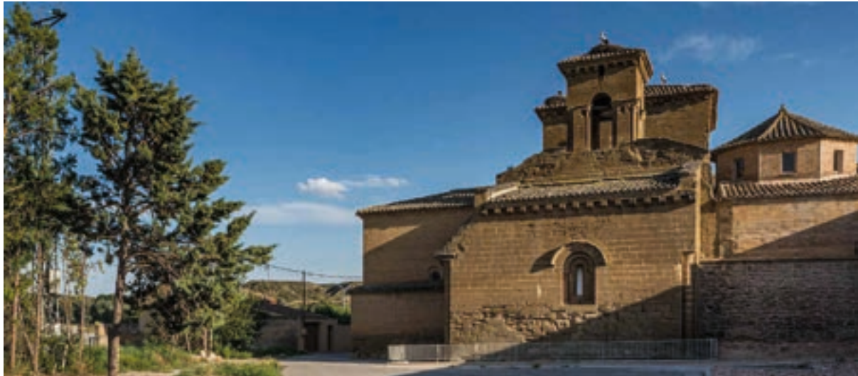
Obras de restauración en el monasterio de Sigüenza 1991 Provincia de Huesca
