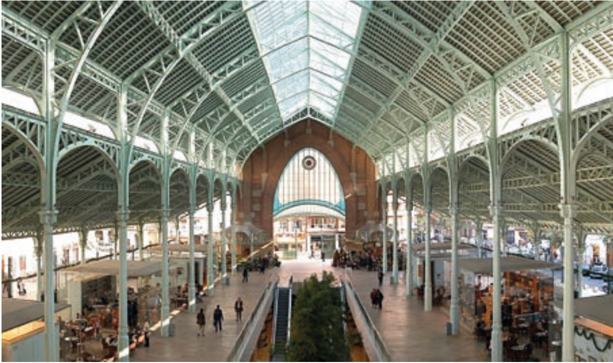
Reforma del Mercado de Colón 2003 Valencia
