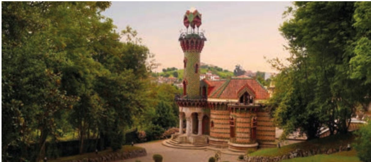
Rehabilitación de el Capricho de Gaudí en Comillas 1990 Comillas (Cantabria)
