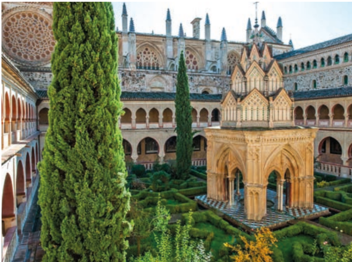
Restauraciones en el monasterio de Guadalupe 1995 Provincia de Cáceres
