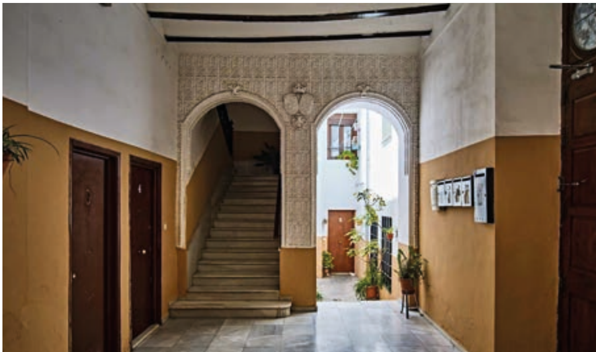
Rehabilitación del palacio de Villarreal en Baeza 1991 Baeza (Jaén)
