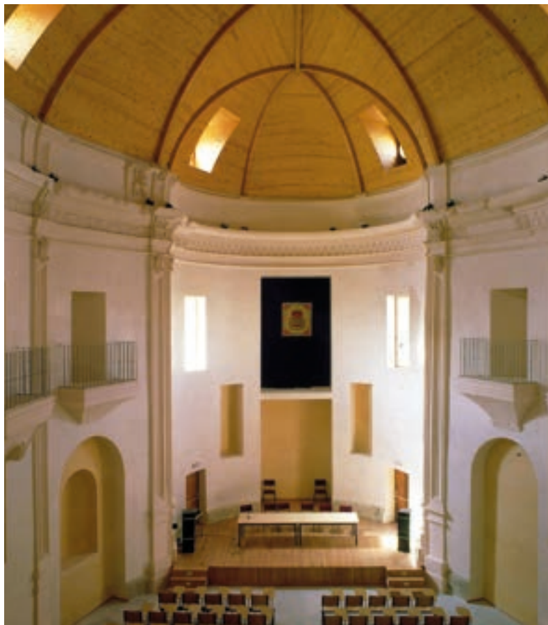
Restauración de la iglesia de los Trinitarios Descalzos en Baeza 1996 Baeza (Jaén)
